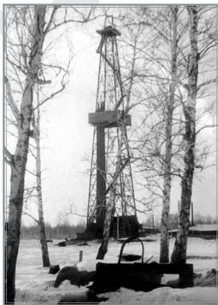
Буровая вышка установлена и готова пробиваться к подземным кладовым...
