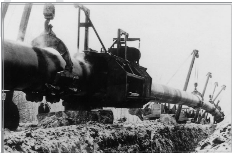
Прокладывание первого нефтепровода Шаим – Тюмень – ответственное дело! (1965 год)
